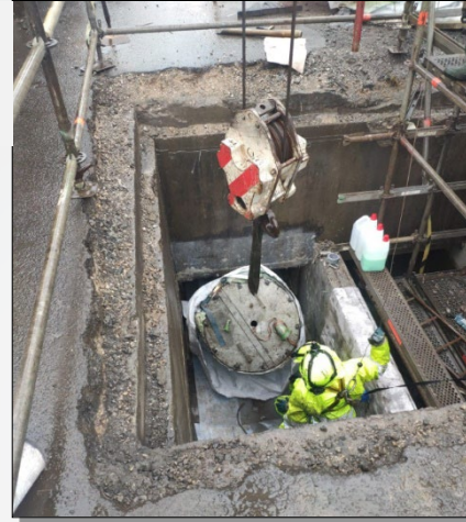
Obturation et insertion du train de lumières
