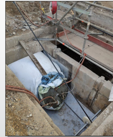
Calibrage et durcissement du revêtement
