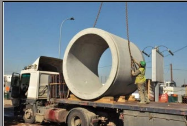
Déchargement d'un tuyau de fonçage sur chantier 28/01/2012
