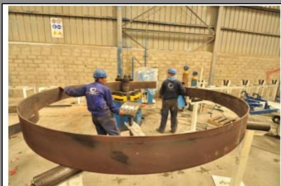
Préparation d'une virole pour tuyau de fonçage Usine LA MEDITERRANENNE DU BETON 30/11/2011
