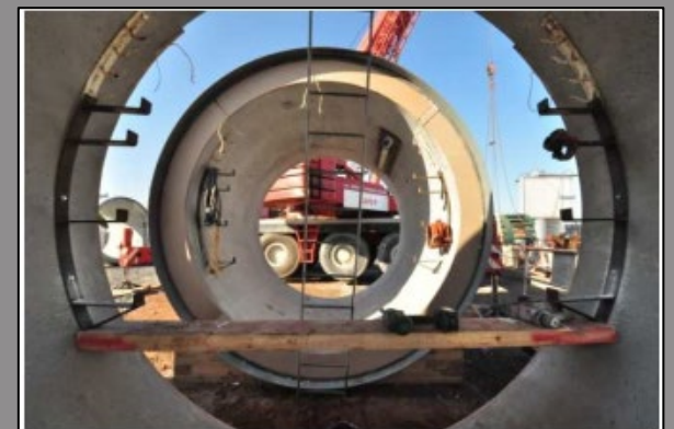
Préparation d'une tuyau de fonçage avant fonçage 28/01/2012
